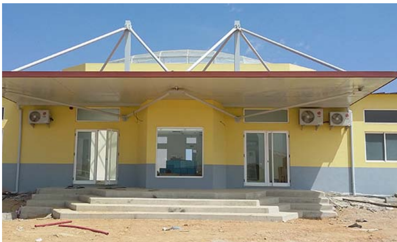
// HOSPITAL PSIQUIÁTRICO DO LUBANGO
